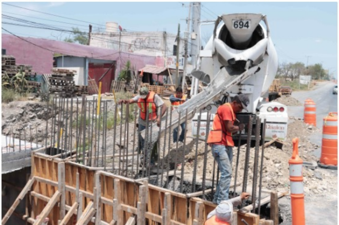
Juárez reporta avance del 65% en obra de drenaje pluvial. Foto: Cortesía.
